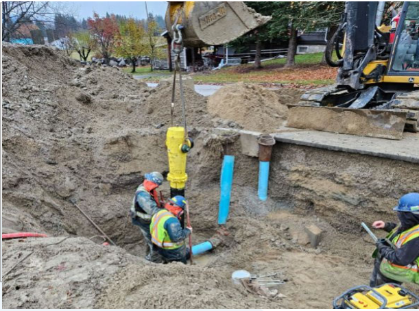
Fauquier mainline construction
